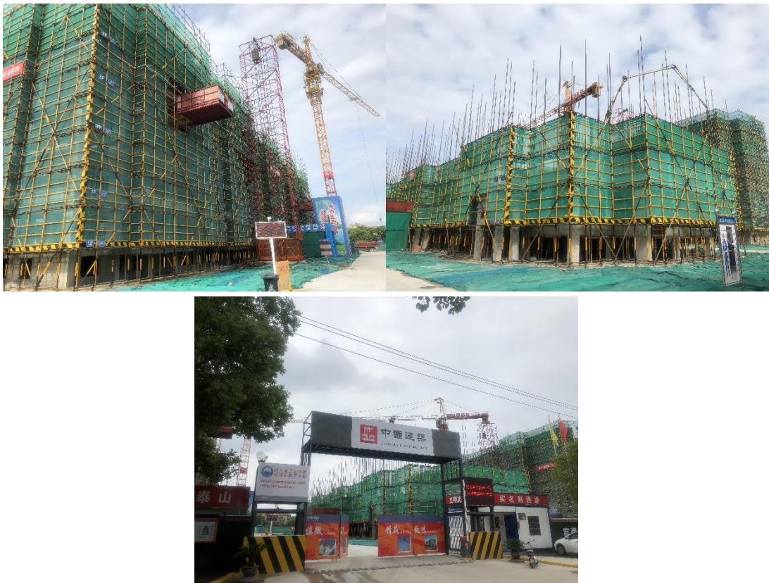
图一 施工期间项目形象
