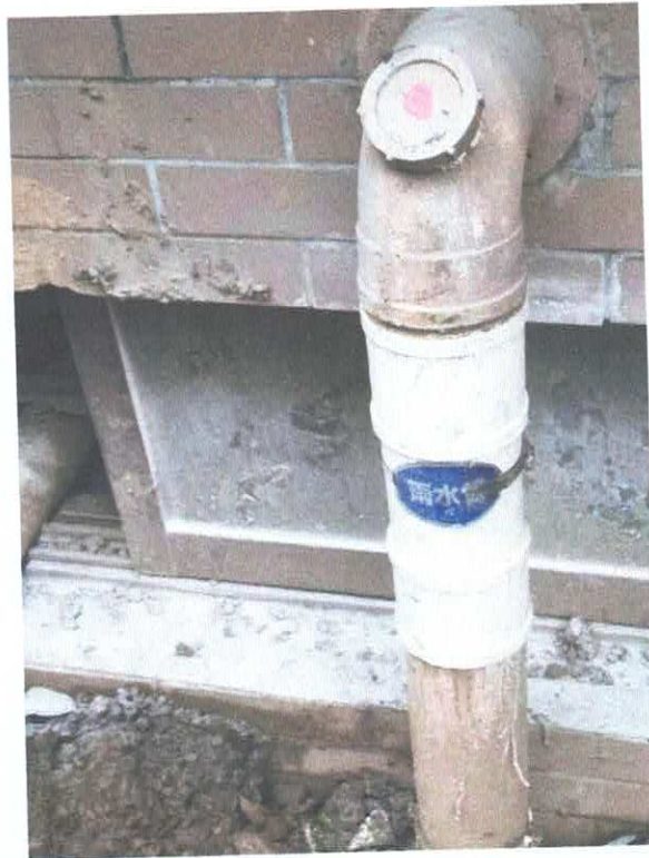
雨水接出管破损整改后
