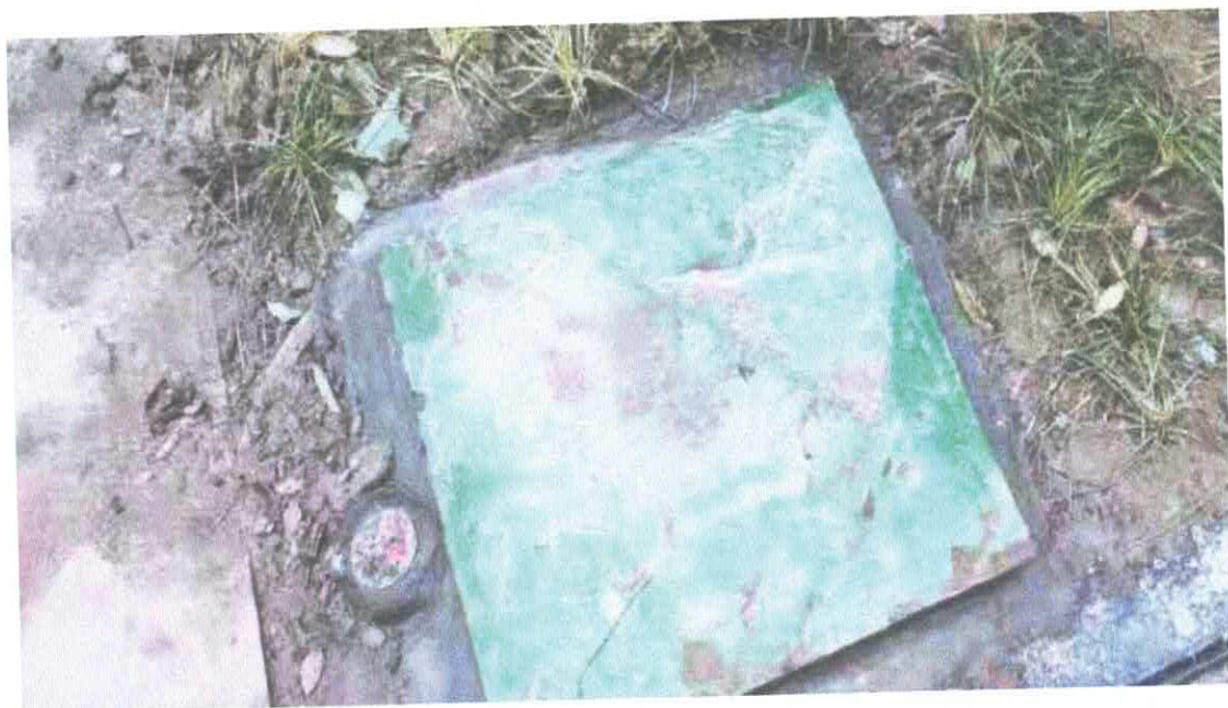
井盖未覆盖整改后
