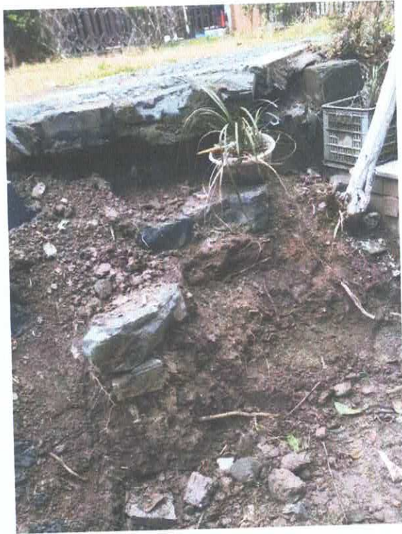
阶梯修复整改前
