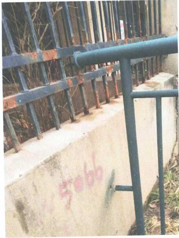
林湖世家护栏加固整改前
