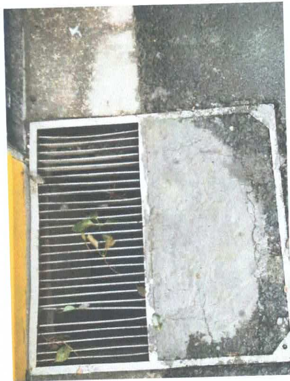
沥青破损修复后
